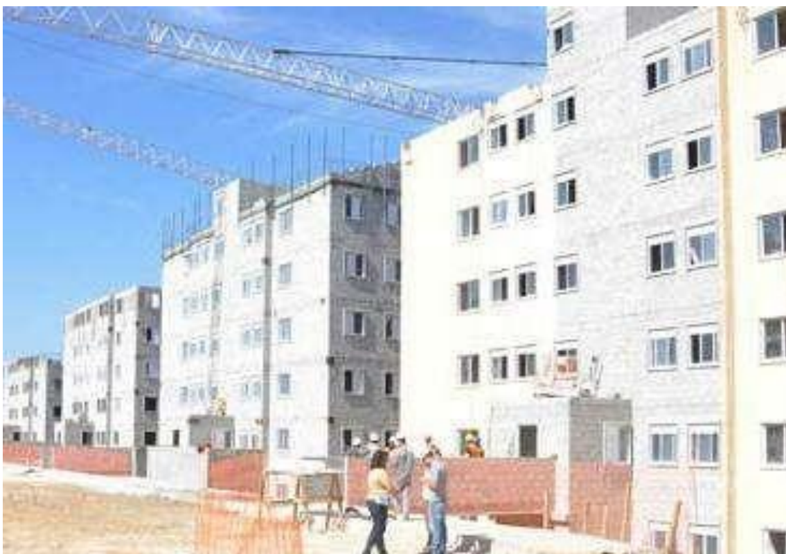
Figura 23 – Construção dos 532 apartamentos destinados à população que reside às margens do Córrego Cadaval. Fonte: Prefeitura Municipal de Carapicuíba.
