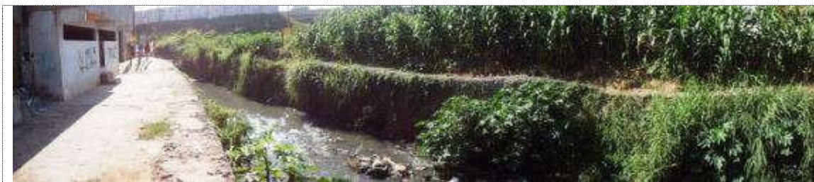
Figura 9 – Curso d'água com revestimento das margens em pedra aramada (gabião)
