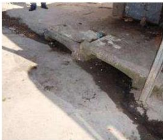
Figura 12 - Detalhe de Boca de Lobo
