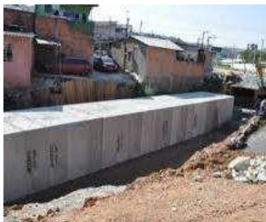
Figura 21 – Canalização do Córrego Cadaval – ligação Córrego Cotia. Fonte: Prefeitura Municipal de Carapicuíba.
