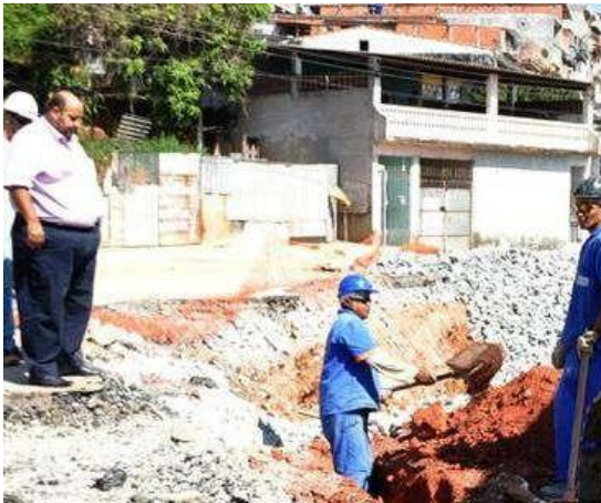
Figura 22 – Canalização do Córrego Cadaval - Vila Sulamericana e Ariston. Fonte Prefeitura Municipal de Carapicuíba.
