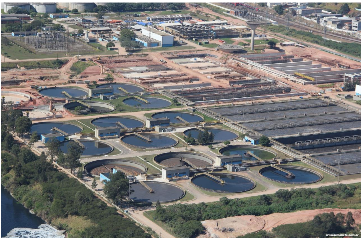
Figura 2 - Vista Geral da ETE Barueri.
