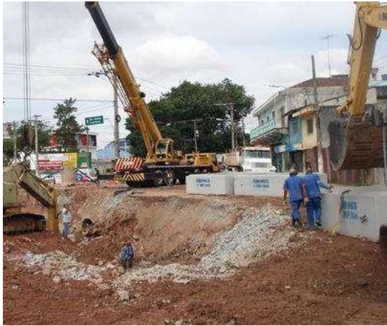
Figura 20 – Canalização do Córrego Cadaval – Vl. Menck/Vl.Sul Americana. Fonte: Prefeitura Municipal de Carapicuíba.
