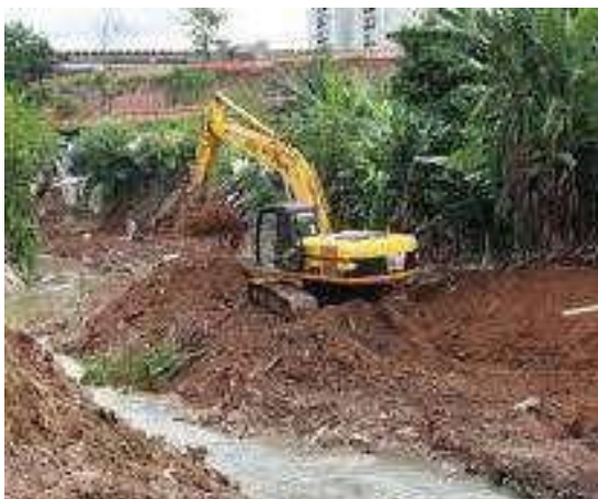
Figura 19 – Canalização do Córrego Cadaval. Trecho Av. Dante Carraro e Rui Barbosa até o Rio Cotia. Fonte: Prefeitura Municipal de Carapicuíba
